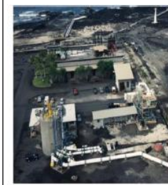
OTEC NELHA, Hawaii, 210 kW
