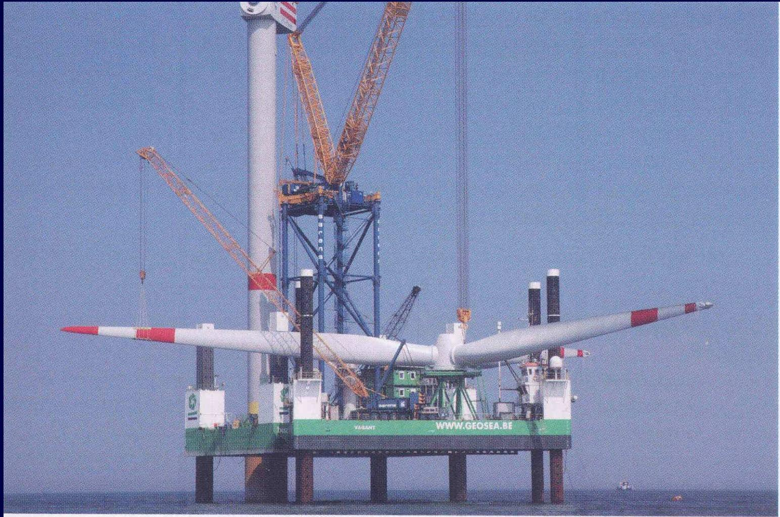
Photo 11 : pose d'hélice de 126 m de diamètre sur son mât dans le parc éolien marin de 300 MW de Thornton bank en Belgique (© Deme, Be).
