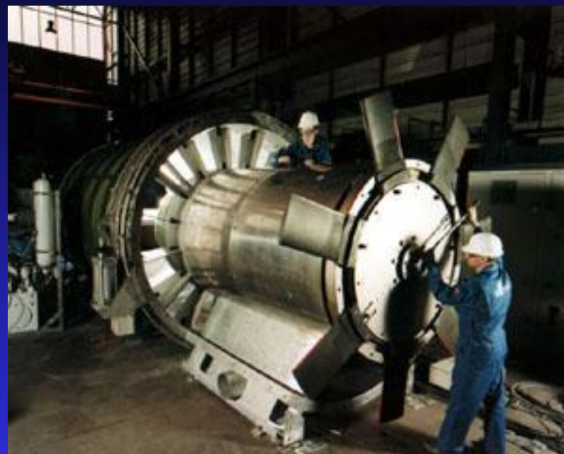
La turbine en cours de montage
