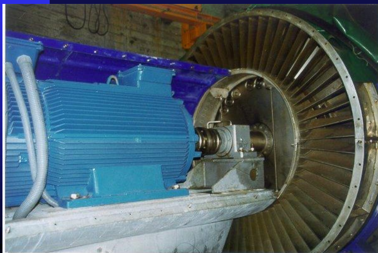
Turbine et générateur 400kW
