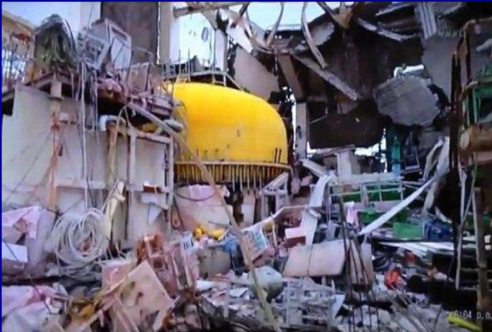
Réacteur N°4. Aperçu du couvercle du drywell
