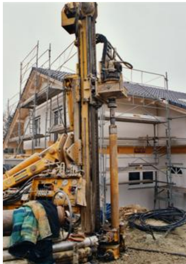
2 sondes géothermiques de 70 m pour chauffer une villa Minergie
