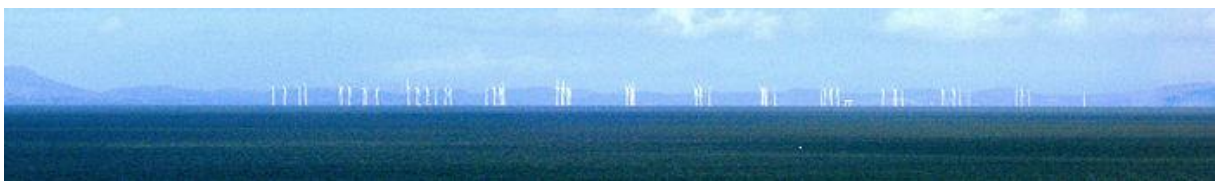
Fig.4 Vue générale du parc Robin Rigg avec au fond la côte écossaise.
